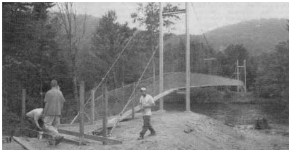
Des travailleurs s'affairaient mercredi à terminer l'accès à la passerelle. (photo: Denise Paquin)
